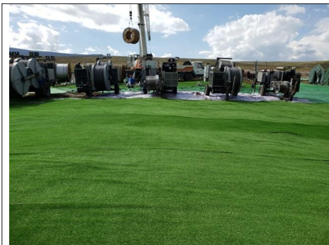
牵张场临时铺垫
