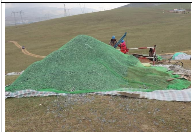
临时堆土苫盖
