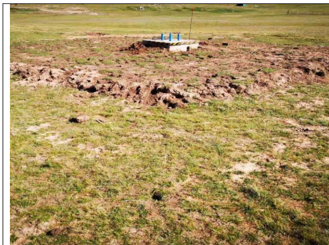
塔基区回覆表土
