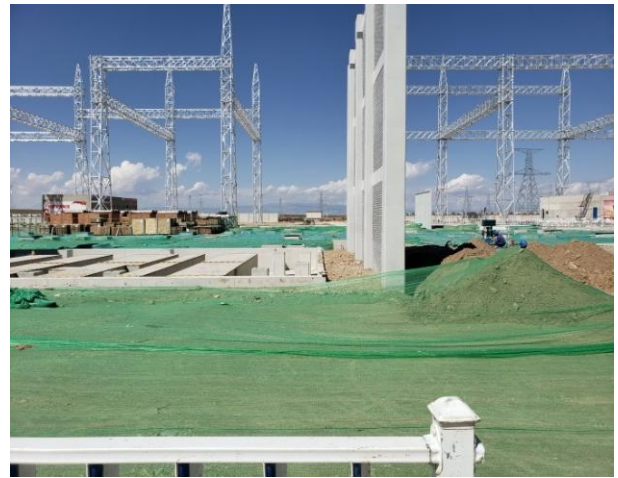
变电站临时铺垫监测
