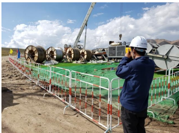
激光测距仪量测牵张场扰动面积
