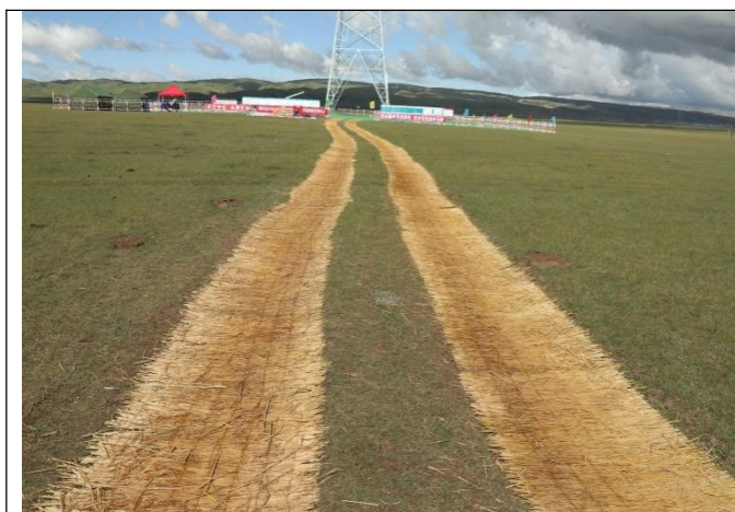
施工道路铺草垫
