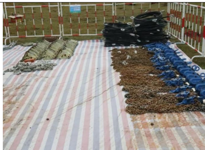
塔基区围栏及铺垫
