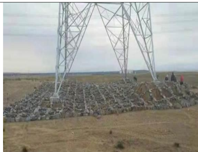
塔基区石方格沙障
