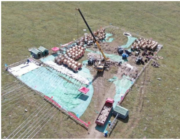
牵张场临时铺垫监测
