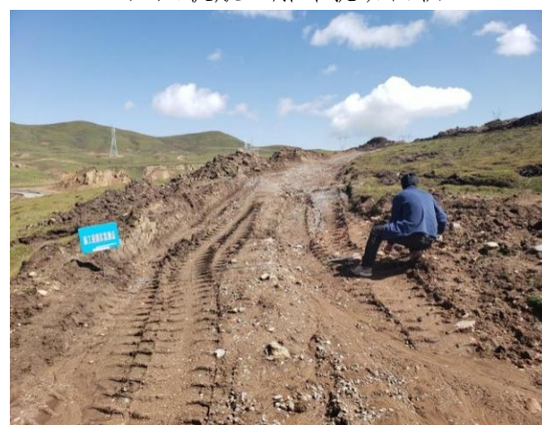
采用皮尺实地测量施工道路扰动宽度
