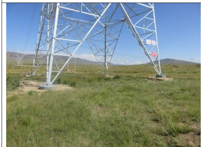
塔基及施工场地植被恢复
