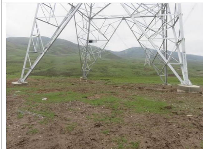
塔基及施工场地植被恢复
