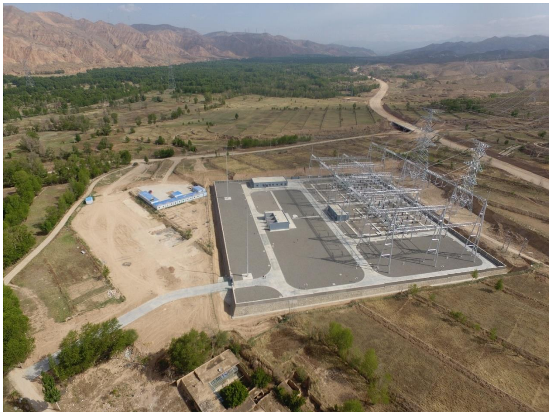
小寨 330kV 开关站 (2019 年 5 月 21 日)
