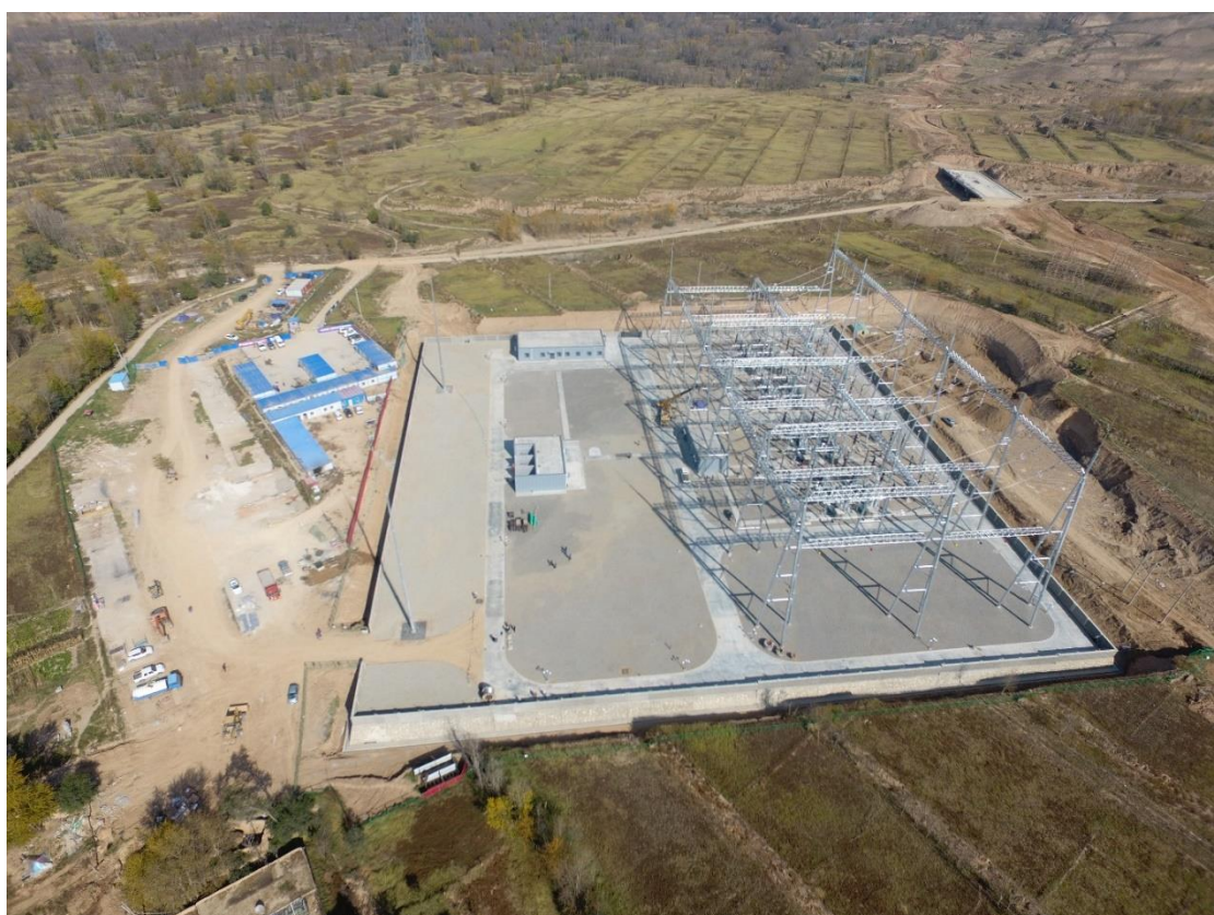
小寨 330kV 开关站 (2018 年 10 月 12 日)
