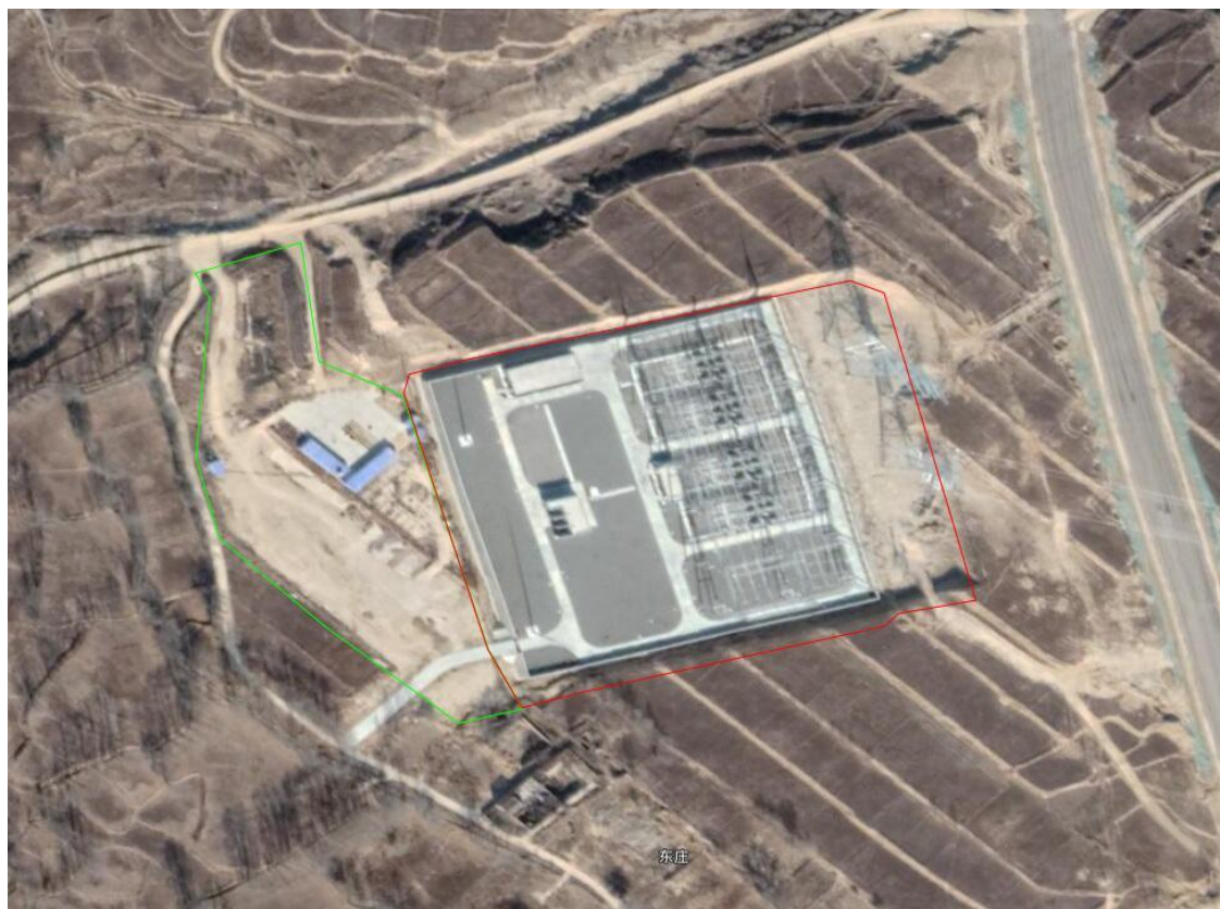
小寨 330kV 开关站 (2019 年 11 月 20 日)
