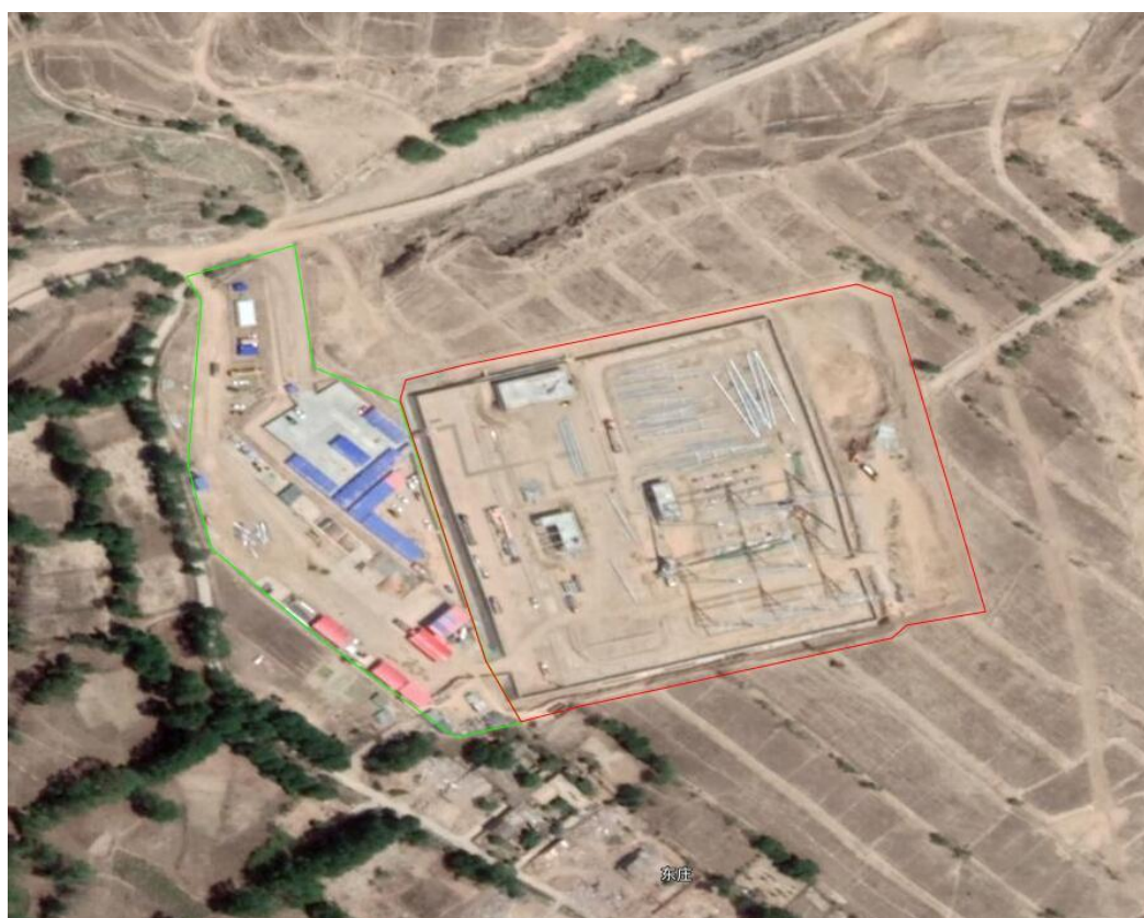
小寨 330kV 开关站（2018 年 5 月 17 日）
