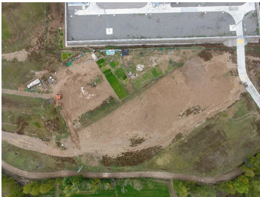
开关站施工临时占地区
