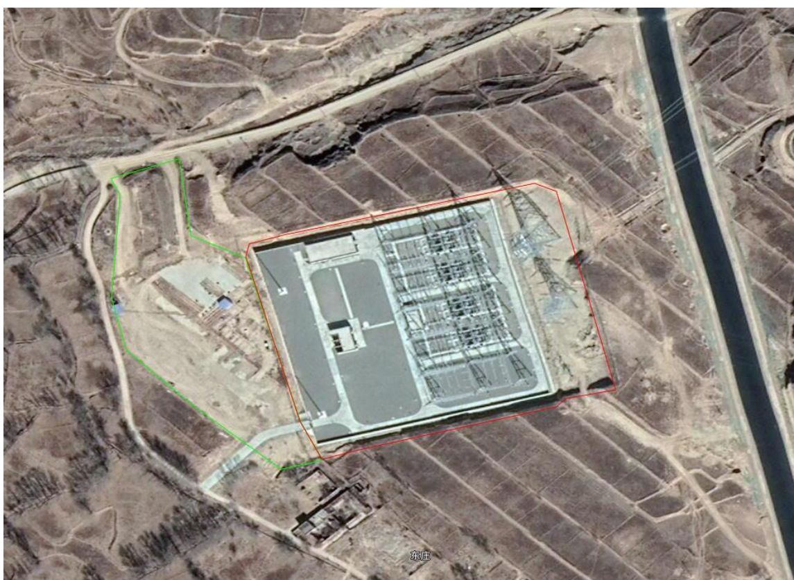
小寨 330kV 开关站 (2020 年 3 月 7 日)
