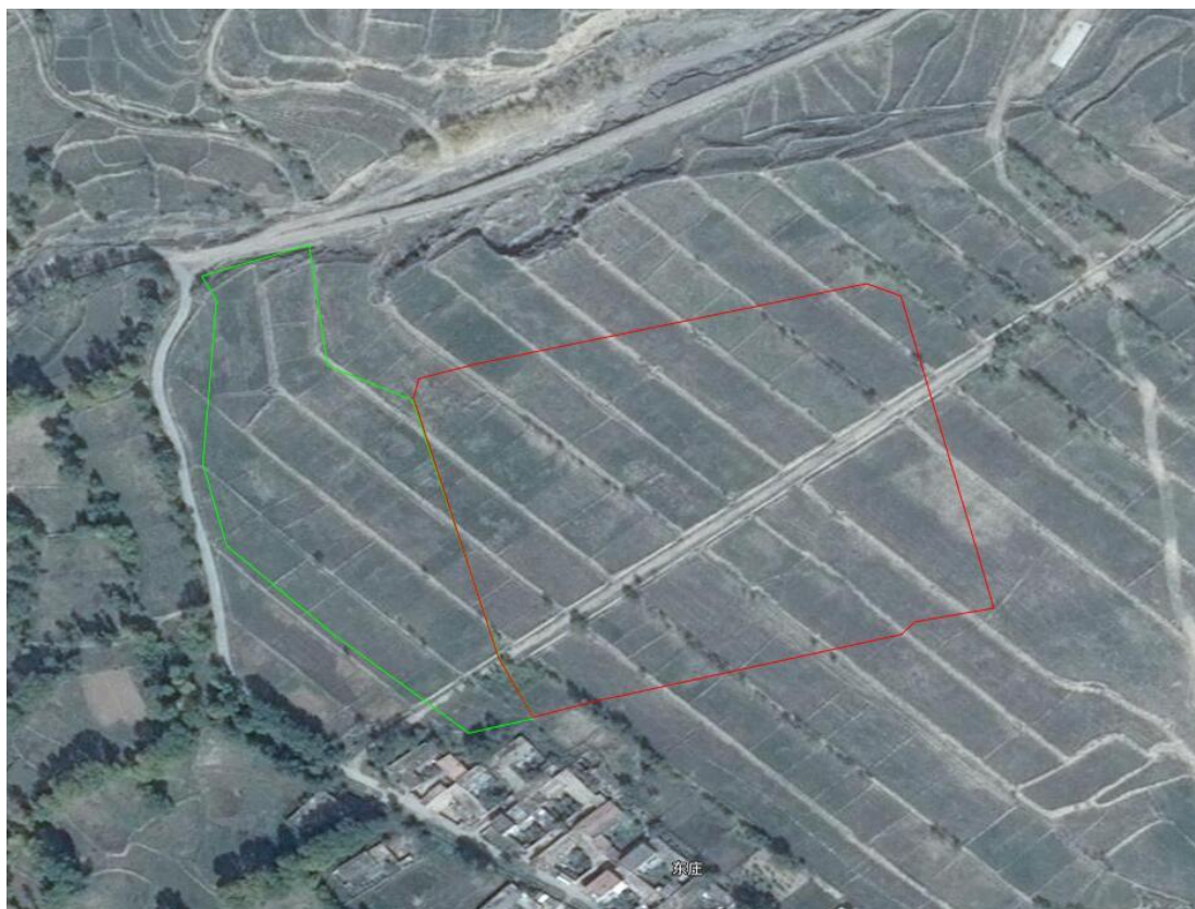
小寨 330kV 开关站（2015 年 10 月 2 日）
