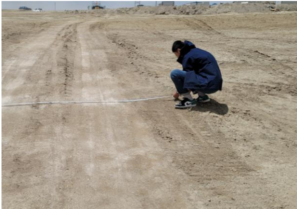
采用皮尺实地测量施工道路扰动宽度
