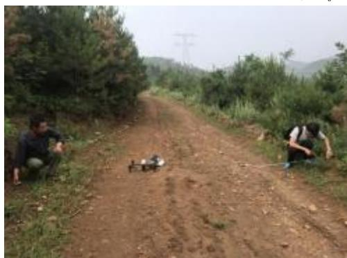
皮尺测量施工道路
