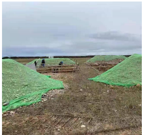
防尘网苫盖施工
