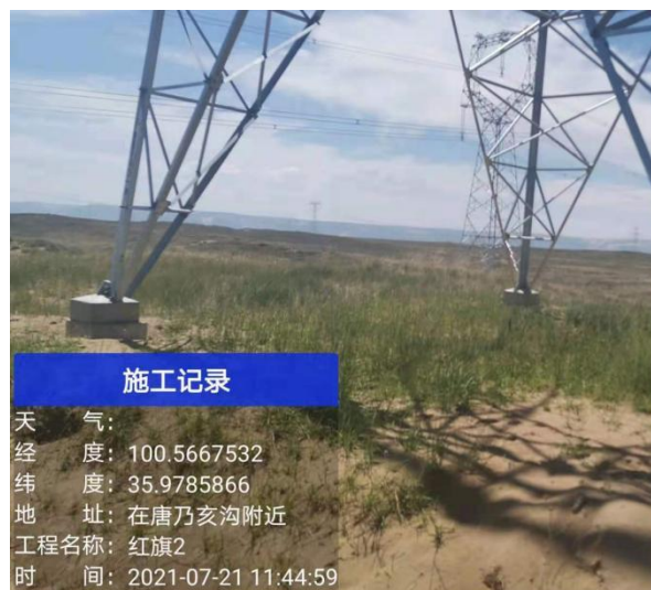
植被成活率及生长较好塔基
