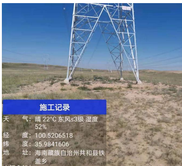
植被成活率及生长较好塔基
