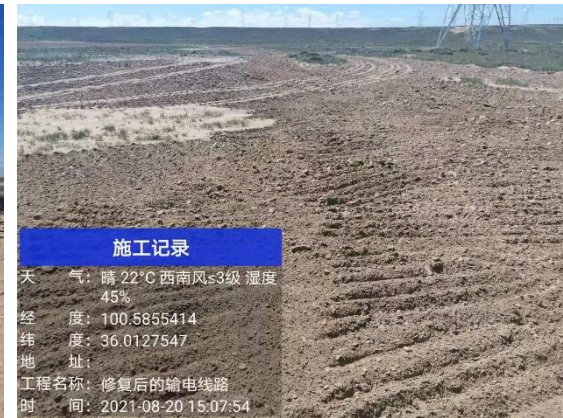
针对施工道路区补种草籽
