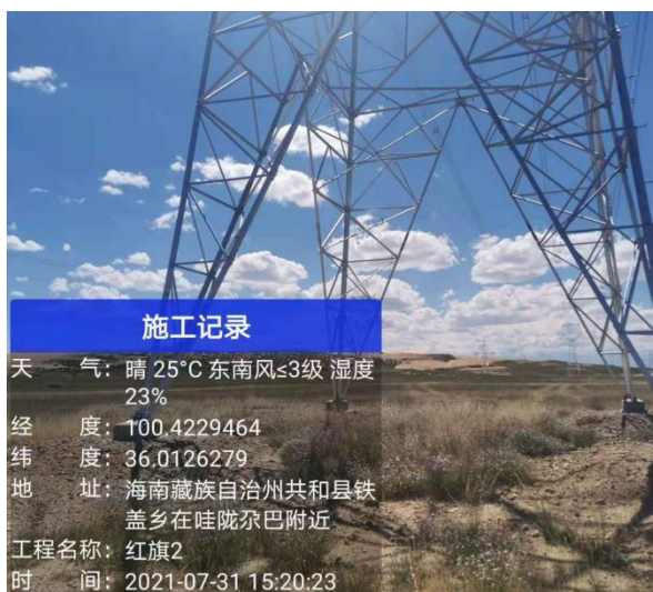
植被成活率及生长较好塔基
