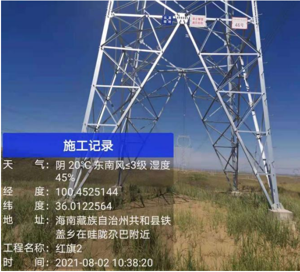
植被成活率及生长较好塔基
