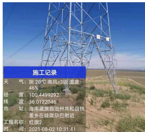
植被成活率及生长较好塔基
