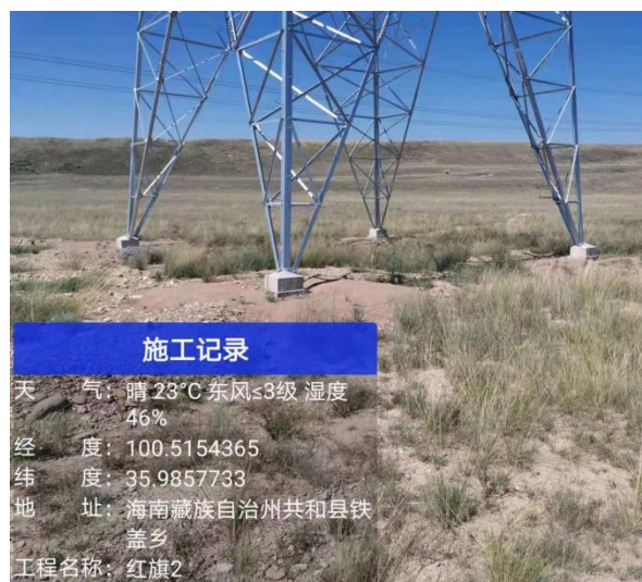
植被成活率及生长较好塔基
