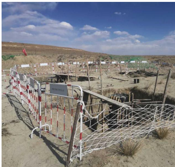
项目施工中划定施工范围线
