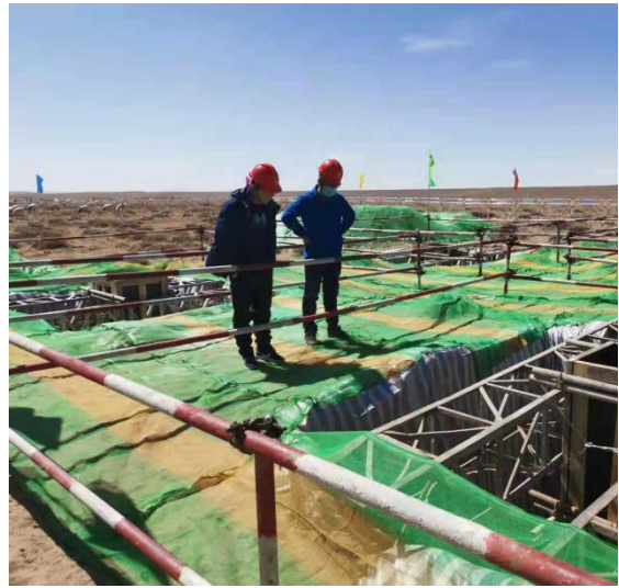
地面苫布苫盖施工
