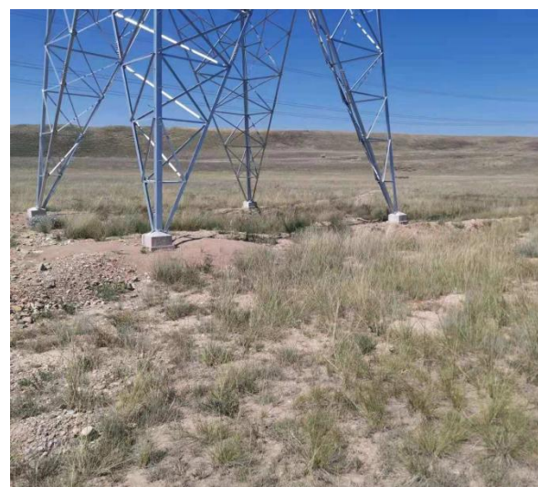
植被成活率及生长较好塔基
