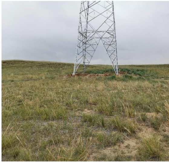
植被成活率及生长较好塔基
