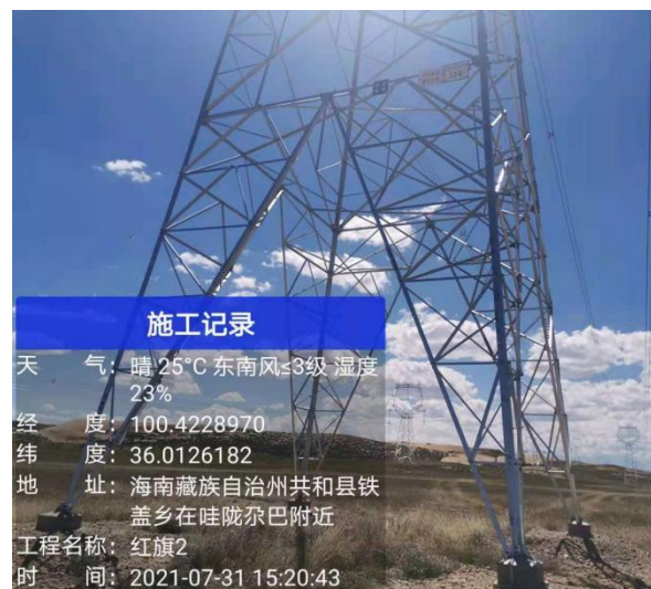
植被成活率及生长较好塔基
