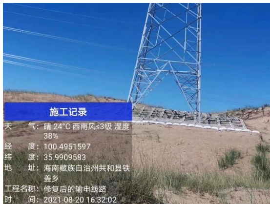
沙袋拦挡措施
