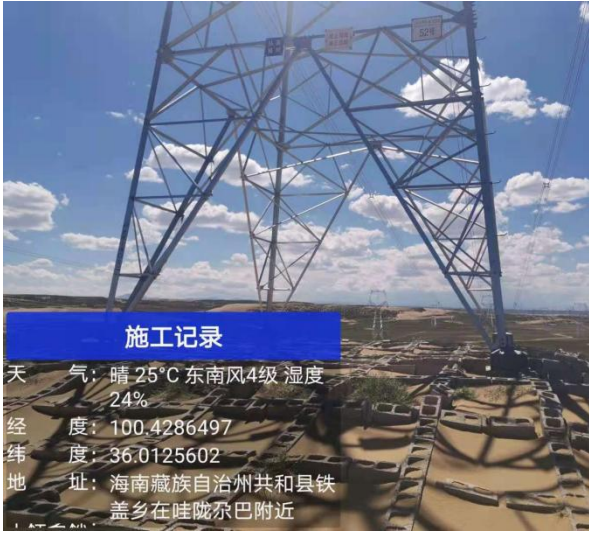
植被成活率及生长较好塔基
