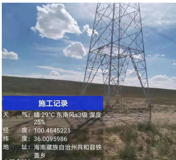
植被成活率及生长较好塔基
