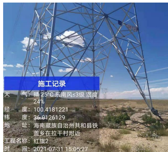
植被成活率及生长较好塔基
