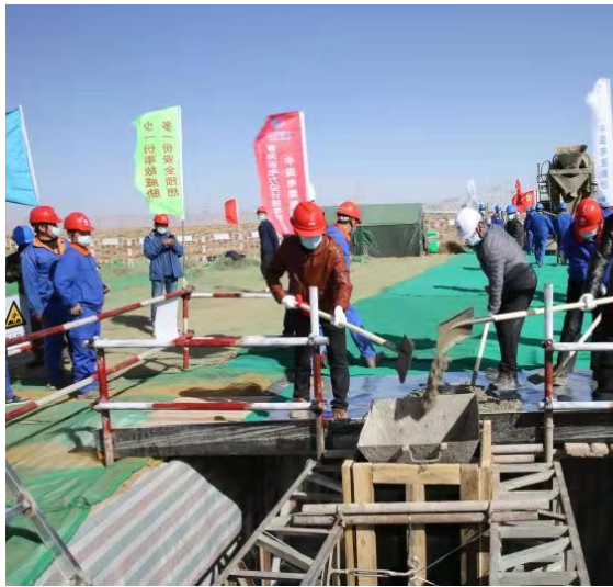
地面苫布苫盖施工
