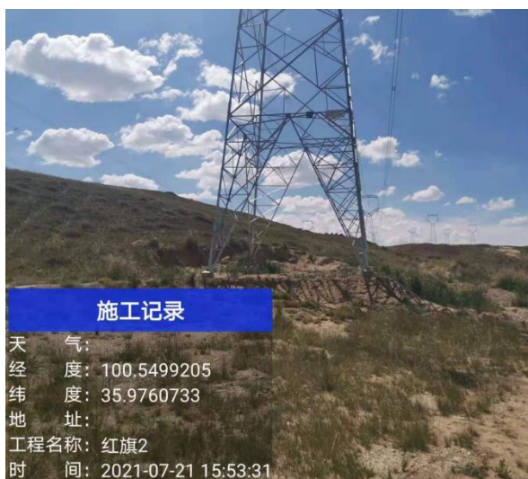
植被成活率及生长较好塔基
