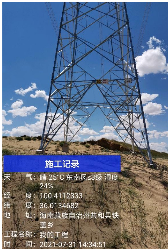
植被成活率及生长较好塔基
