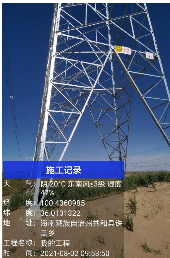
植被成活率及生长较好塔基
