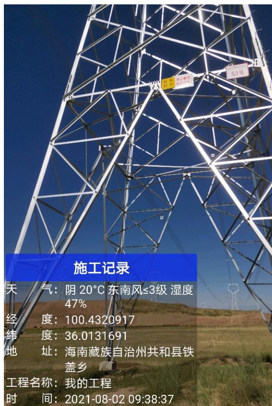
植被成活率及生长较好塔基
