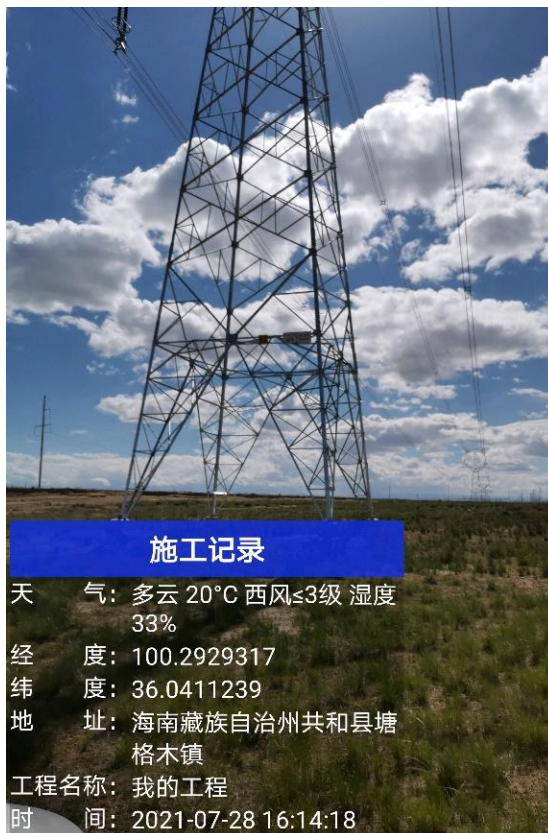
植被成活率及生长较好塔基
