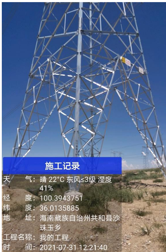
植被成活率及生长较好塔基
