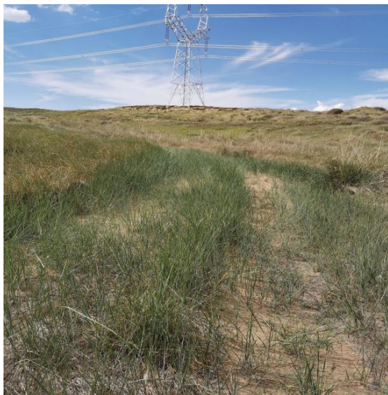
施工道路植被恢复现状
