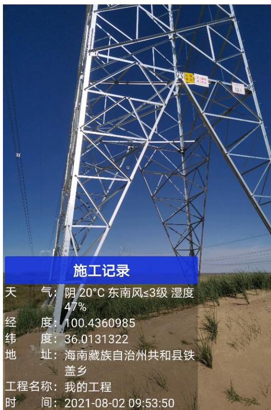
植被成活率及生长较好塔基
