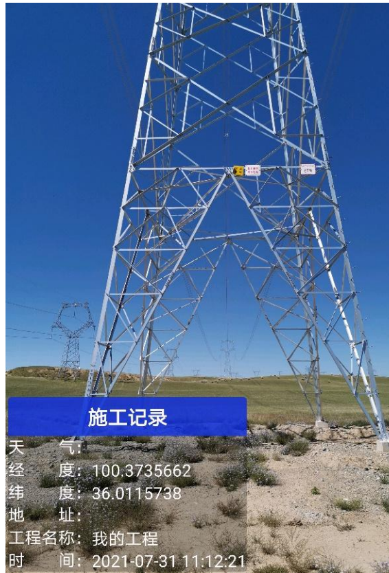
植被成活率及生长较好塔基
