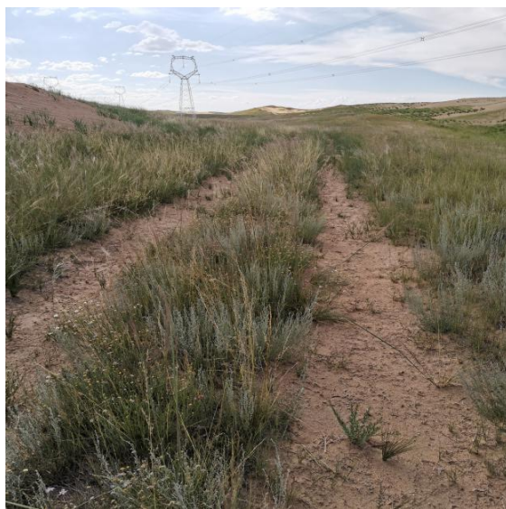
施工道路植被恢复现状
