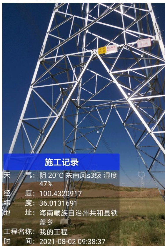
植被成活率及生长较好塔基
