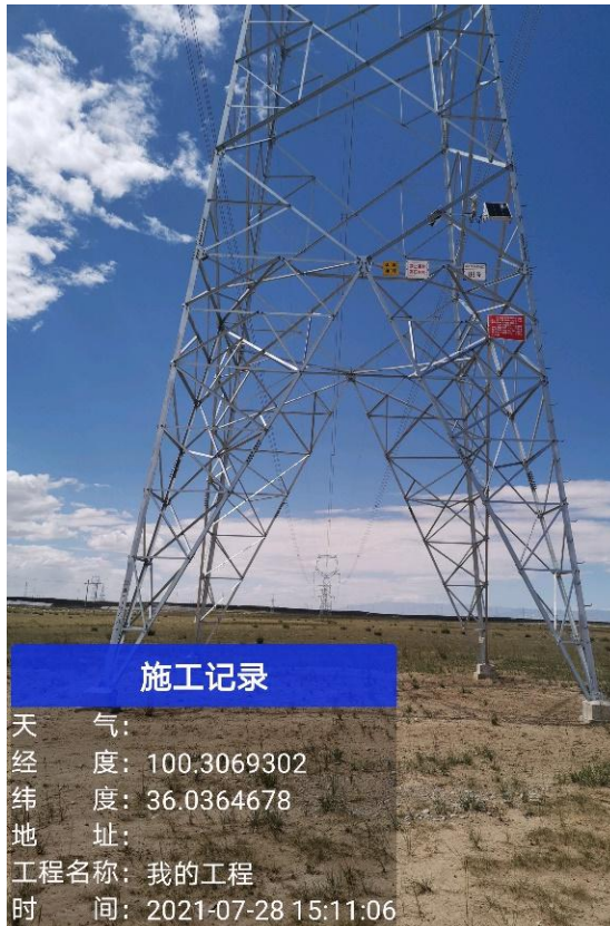
植被成活率及生长较好塔基
