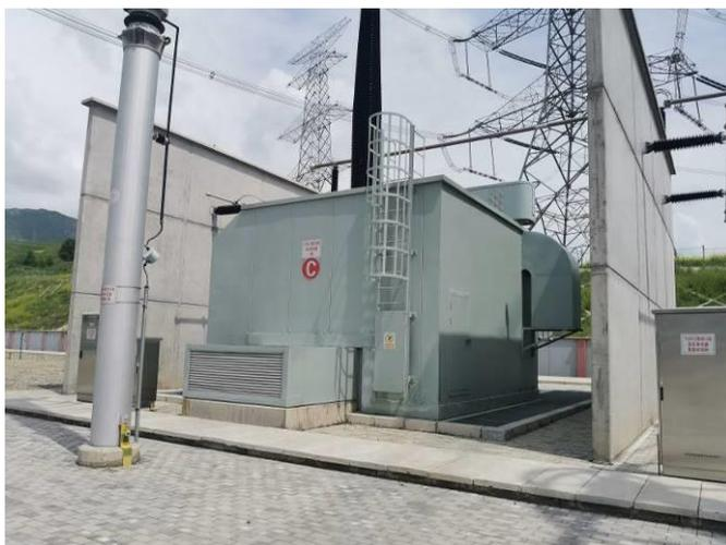
图 3.8-1 750kV 变电站典型噪声控制措施实例
