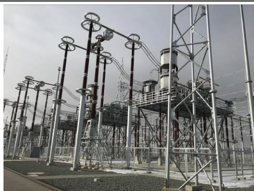
海西 750kV 变电站串补站侧站内硬化和碎石铺设
