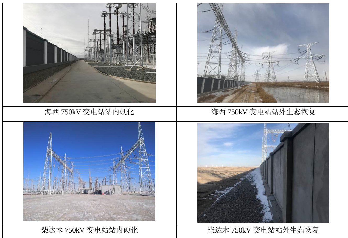
图 6-1 本工程生态措施现场照片
