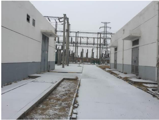
站内道路及硬化地面
