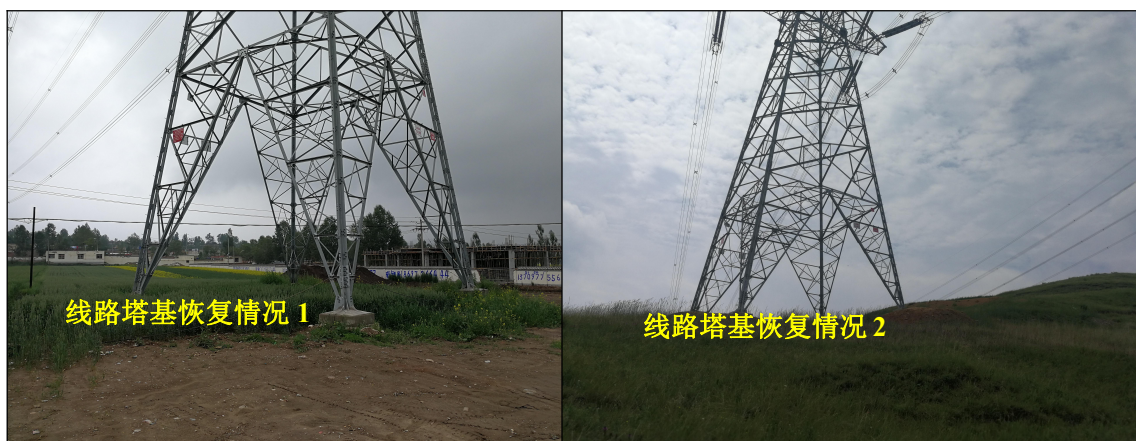
图6-3 塔基生态恢复情况
